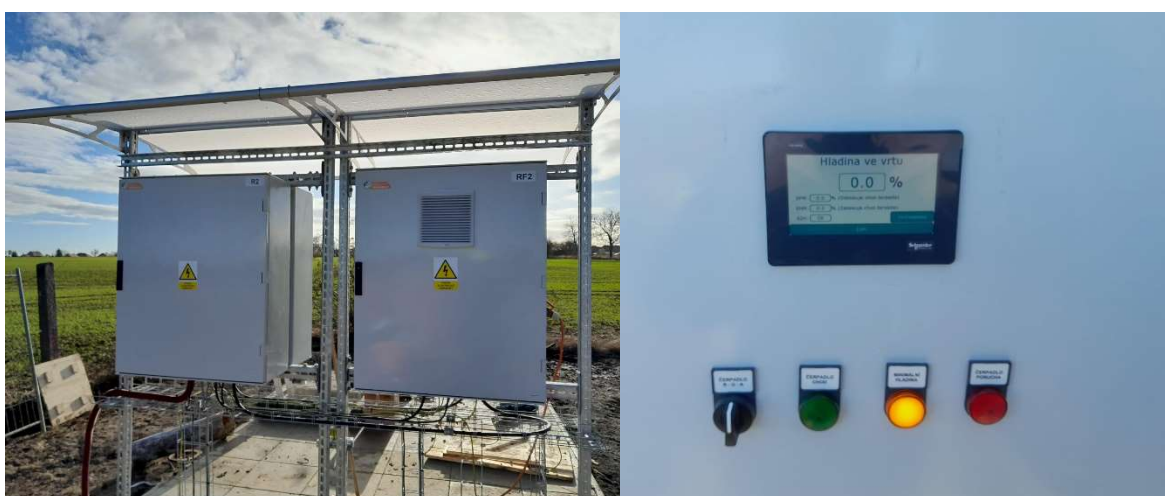
Obr. č. 3: Eletrozázemí vodárenské studny vč. MaR a integrovaného kalibračního modulu „hydrogeolog“ (zdroj: J. Průša)
